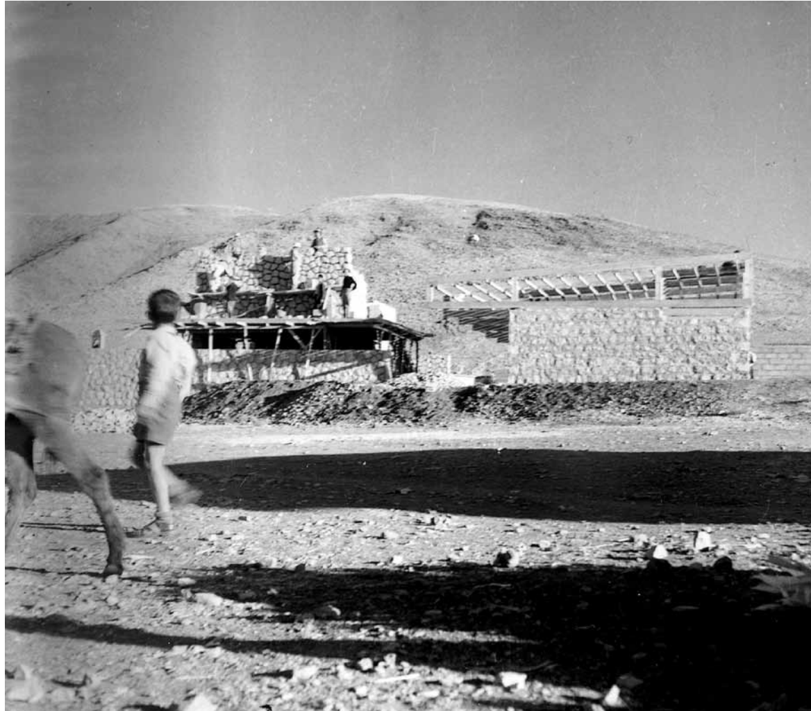
^ Hans Demarmels erstes grosses Werk im Bau: die Schule in Anjaar, Libanon.
