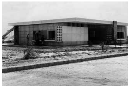
< Ab 1956 entstanden in Kirkuk, Irak, Häuser aus Fertigbeton-Elementen, die Demarmels entwickelt hatte.
